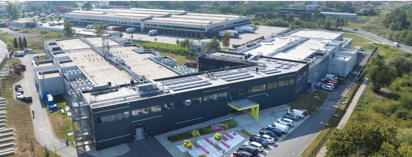
Rechenzentrum DC7 – das modernste Rechenzentrum in Tschechien, das höchste Sicherheit, Verfügbarkeit und Zuverlässigkeit für die geschäftskritische Infrastruktur von Unternehmen garantiert Datové centrum DC7 – nejmodernější datové centrum v České republice, garantující nejvyšší úroveň bezpečnosti, dostupnosti a spolehlivosti pro klíčovou infrastrukturu firem
